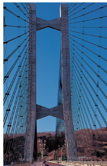
秩父公園橋(埼玉県)
