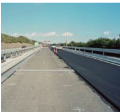
④施工完了
