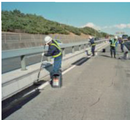
①シート部プライマー塗布
