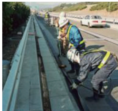
③転圧 &amp; ラップ部バーナー接着
