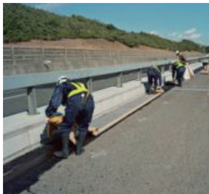
②シート敷設
