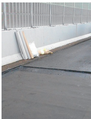
⑦施工完了
