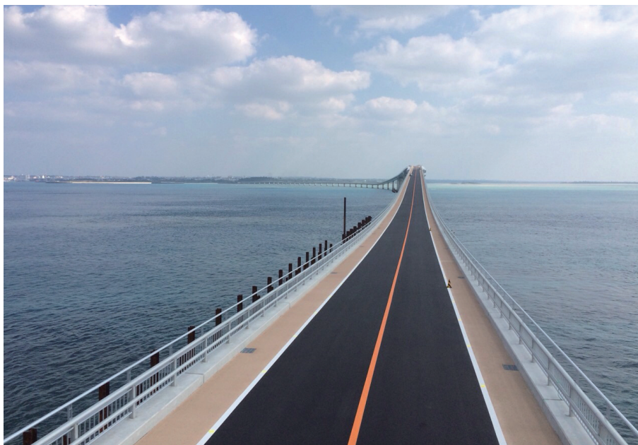
伊良部大橋(沖縄県)
